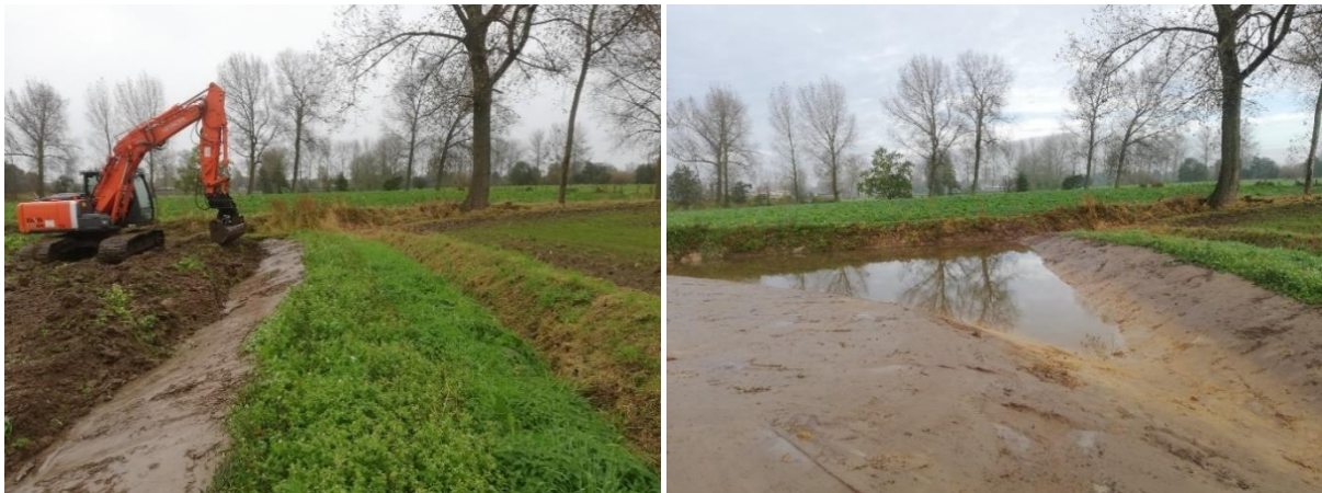
Figuur 4.6. Graafwerkzaamheden voor de poelen in het Vels Voedselboske in de natte herfst van 2023 (© Kris Heirbaut, Heirbaut aLgriculture).
