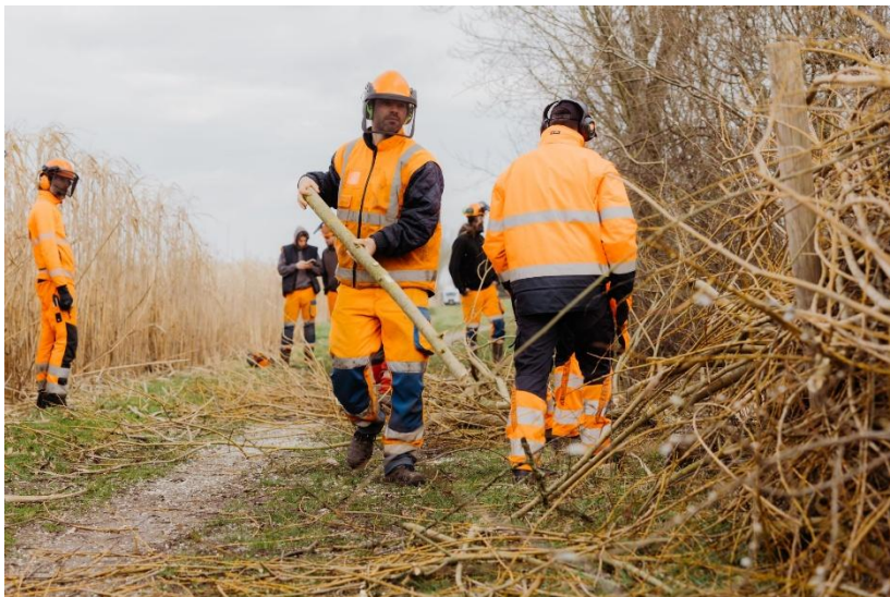
Figuur 34. De bouw van een takkenril: het zwaardere takhout kan dienen als structuurhout voor de ril, het fijnere snoeihout kan tussen deze takken gestapeld worden. © LEADER Waasland
