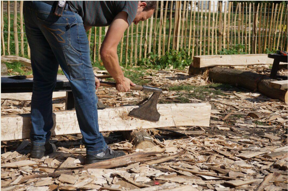
Figuur 5: Tijdens de Stage Vakwerk doorlopen cursisten alle stappen van het bouwen van een vakwerk, van boomstammen kantrechten tot het kloven en leggen van houten dakspanen (shingles), uitsluitend met behulp van handwerktuigen. © het MOT, Grimbergen
